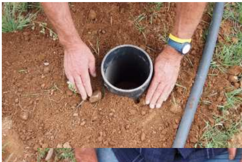
Relleno del entorno exterior del tubo y preparación del sustrato
